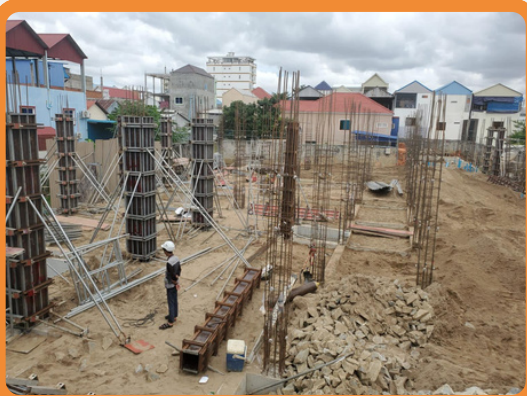
2022年10月 完成地基工程
